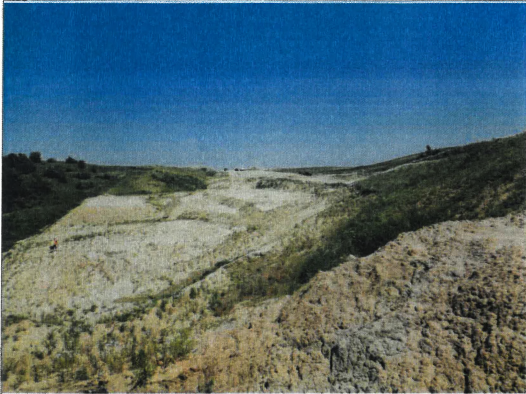
Usunięta część nasypu drogowego z obszaru osuwiska.
