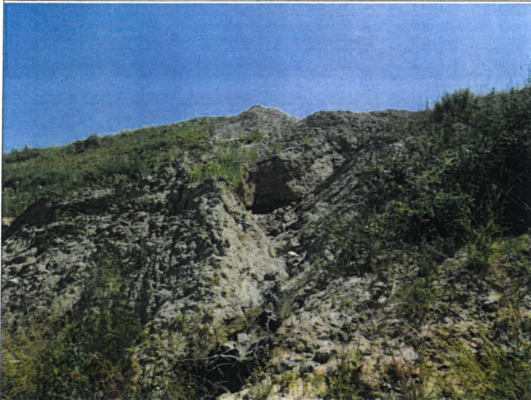
Skarpa główna zasypana gruntami nasypowymi.
