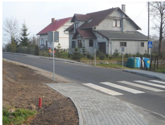
Zdjęcie 11.2.2 Droga powiatowa Nr 1248N – fragment nawierzchni w stanie technicznym dobrym
