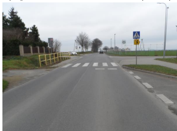
Zdjęcie 11.2.2 Droga powiatowa Nr 1335N – fragment nawierzchni w stanie technicznym dobrym
