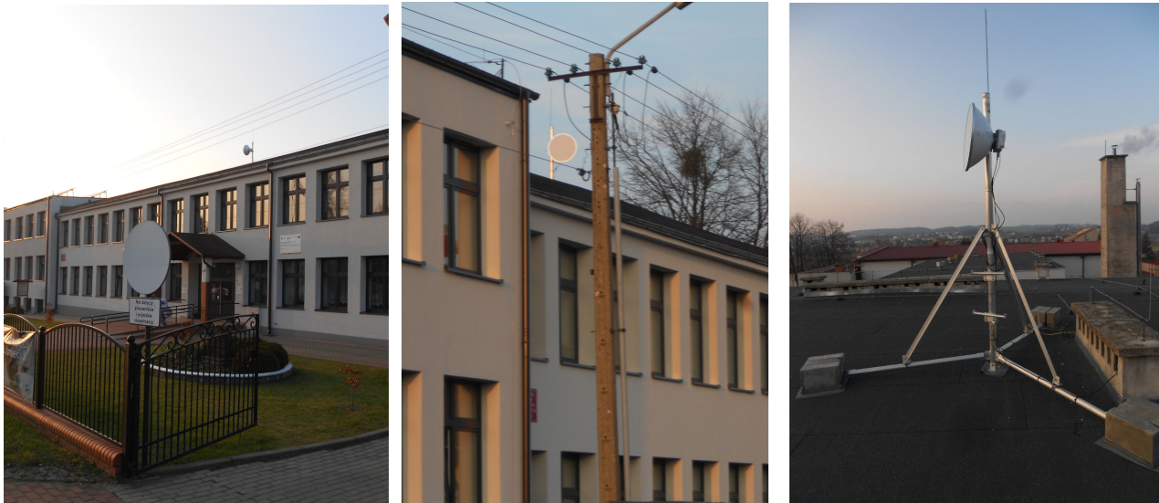
Widok obiektu wraz z zainstalowanym zespołem antenowym
