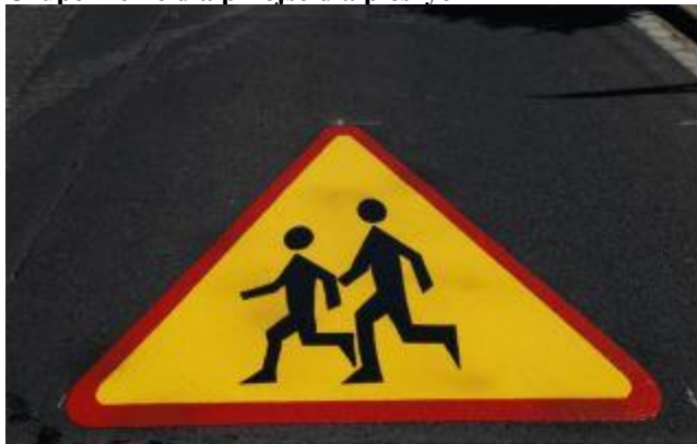
Znak A-17 („uwaga dzieci”) zastosowany na jezdni jako wzmocnienie znaku pionowego. Odblaskowy, dobrze widoczny przed świtem, po zmroku oraz przy opadach atmosferycznych.
